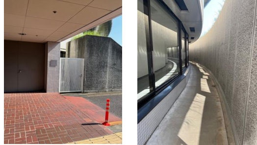
②で愛ドーム南東 (1階)
